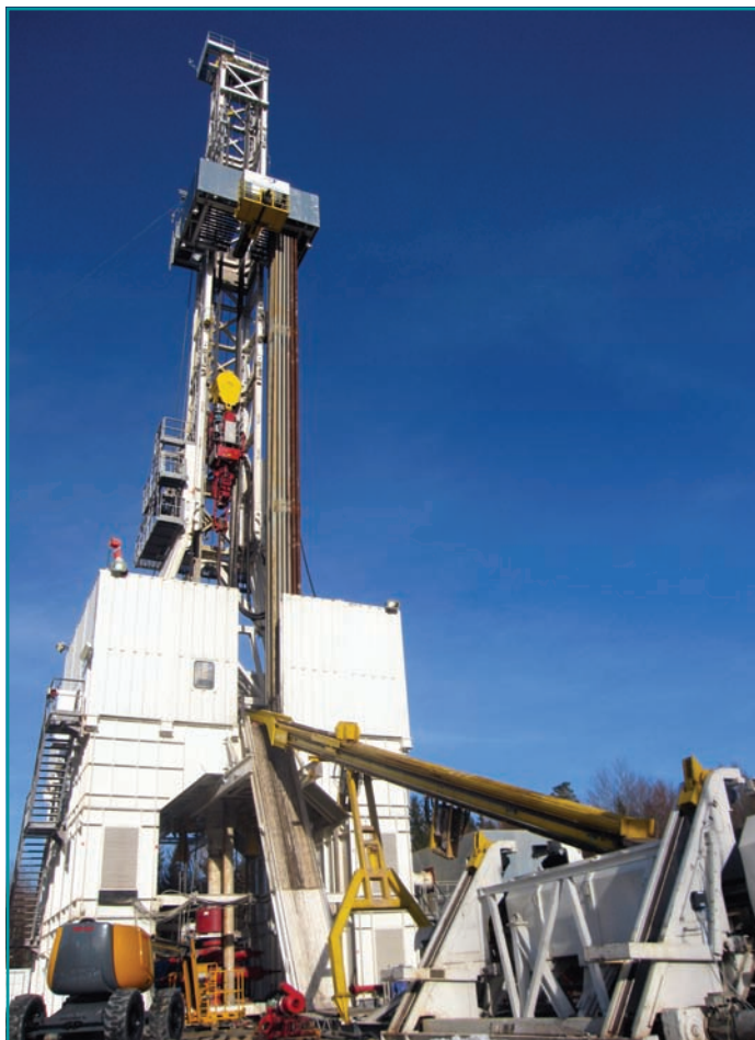
Abb. 1: Bohranlage Hekla Rig 002 - Bentec Euro Rig 350t AC am Bohrplatz in Pullach. Quelle: Erdwerk
